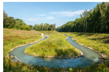
Gewundener Verlauf: Die neue Fischwanderhilfe Greifenstein fügt sich harmonisch in die Landschaft.
