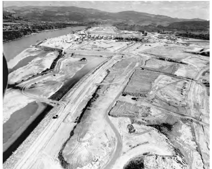
Diese Fotos stammen vom Bau des Donaukraftwerks Ottensheim-Wilhering aus dem Jahr 1971. Es versorgt fast 250.000 Haushalte mit Strom aus Wasserkraft.
