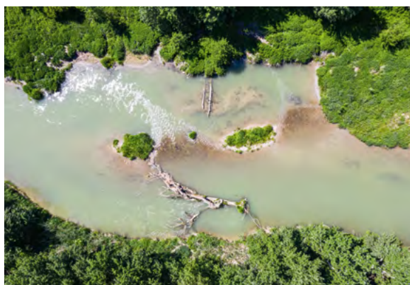
Links: Auf 14,2 Kilometern Länge umfasst die Fischwanderhilfe Ottensheim-Wilhering Tiefstellen, Furten und Buchten für Huchen (Bild rechts) und weitere Fische sowie Wasserlebewesen.
