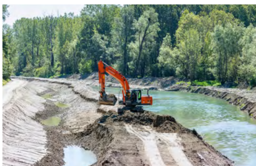
Links: Das Bett der Fischwanderhilfe Abwinden-Asten während des Baus
